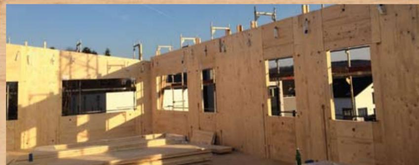
Bauelemente aus Brettsperrholz sind besonders massiv, maßhaltig und formbeständig, dabei äußerst wärmedämmend und gleichzeitig filigran. Sie lassen sich vorfertigen und schnell montieren, können aber dennoch auf der Baustelle leicht bearbeitet werden. Dieser Baustoff ist homogen, stabil, langlebig und gleichzeitig natürlich und umweltfreundlich. Die vorgefertigten Bauelemente für Außen- und Innenwand, Decke und Dach lassen sich schnell und problemlos zu einem behaglichen
